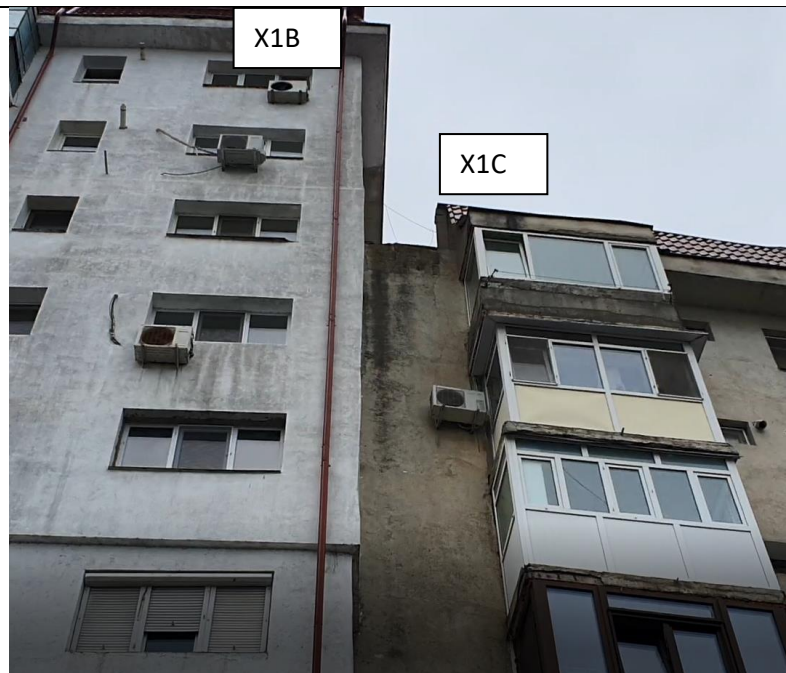
Figura 9: Fațada sudica - X1C+X1B
