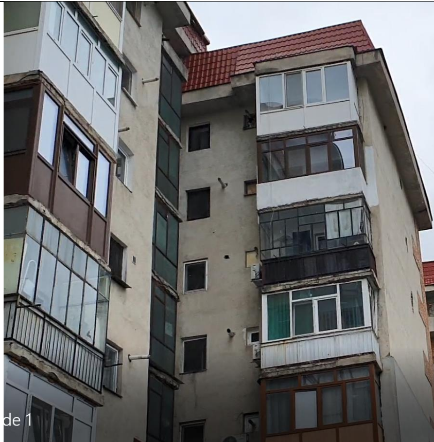
de 1 Figura 8: Fațada sudica - X1C
